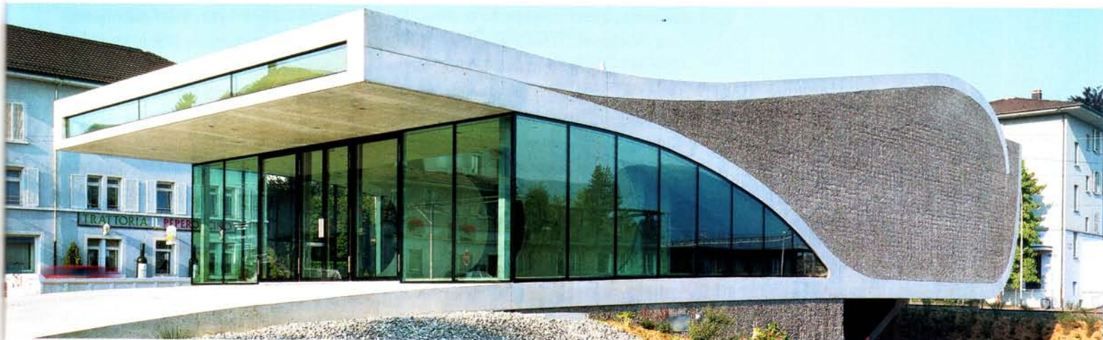
Eingangsbereich mit Vordach.
