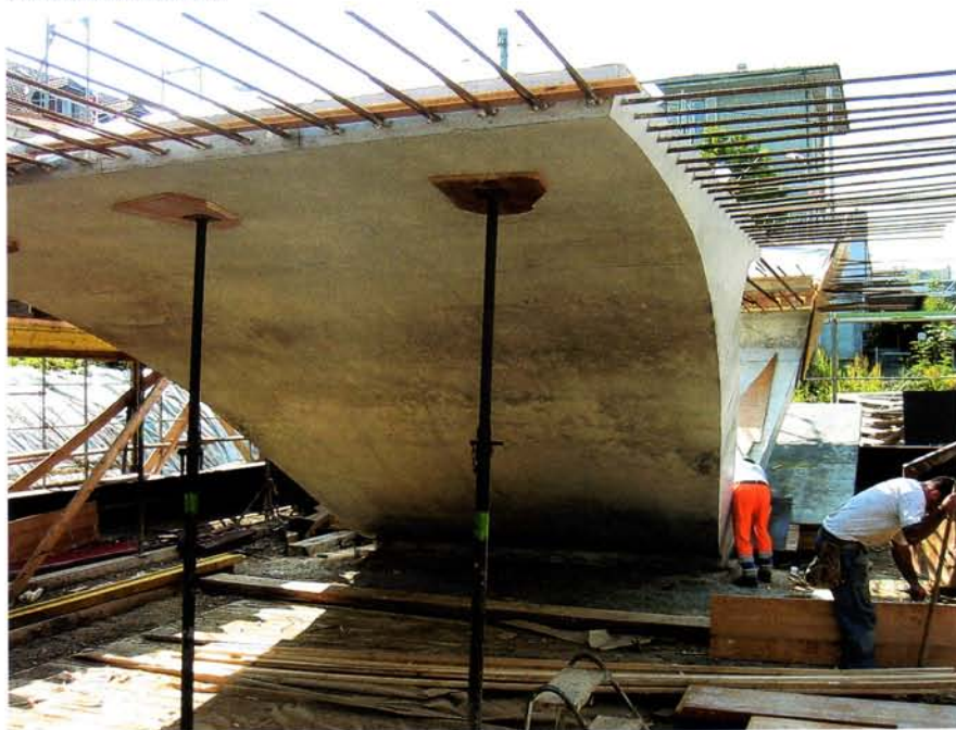
V-Stütze im Bauzustand.
